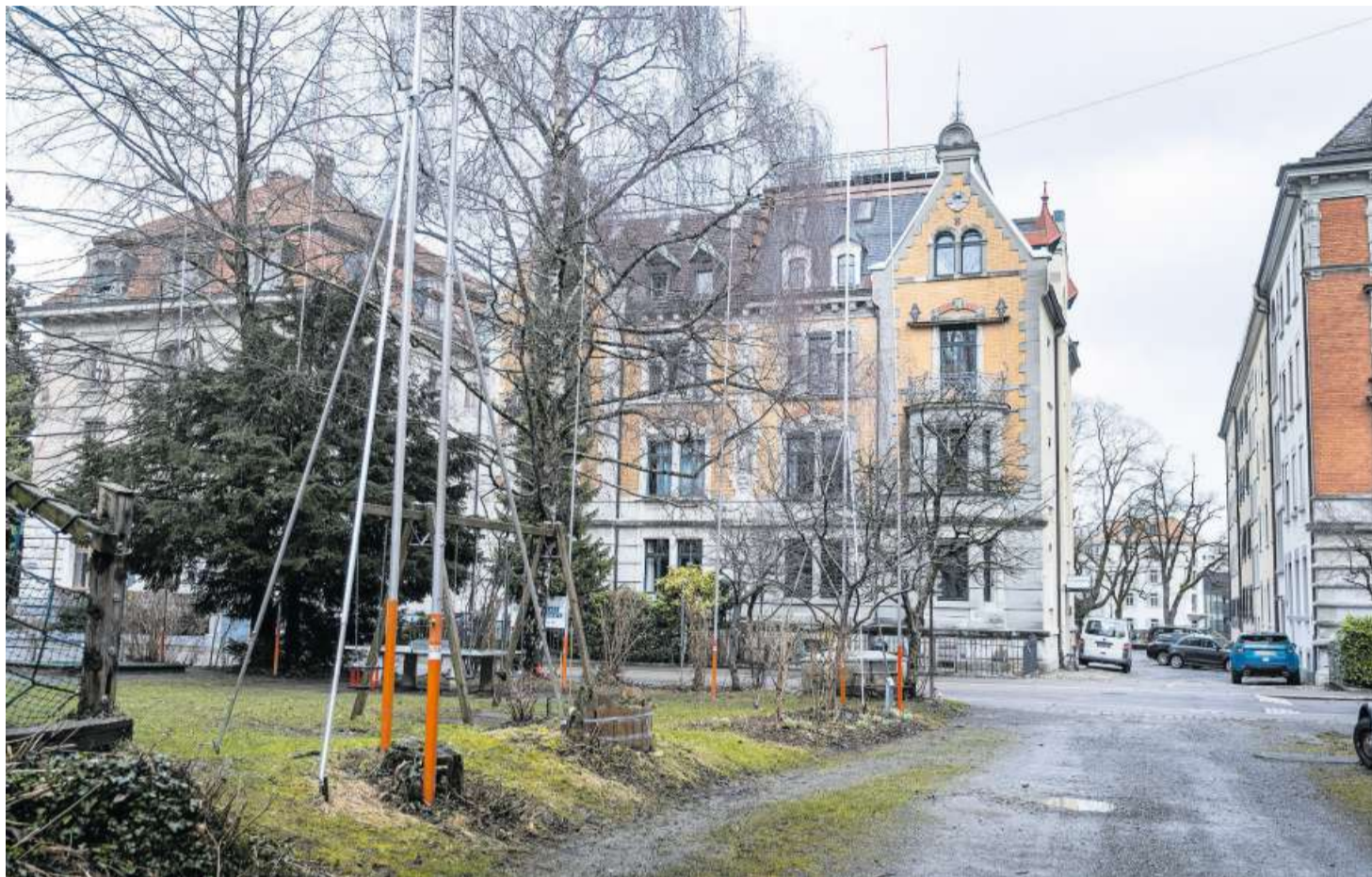
Seit über einem Jahr stehen Visiere auf dem «Wiesli» – solange dauert das Baubewilligungsverfahren inzwischen.
